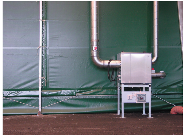
DST Entfeuchter Recusorb DR-40, installiert in einer Zelthalle
